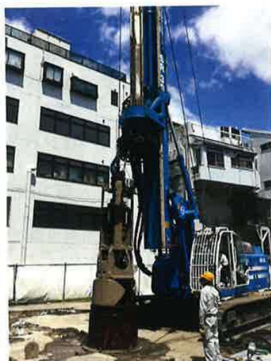
マルチドリル工法
