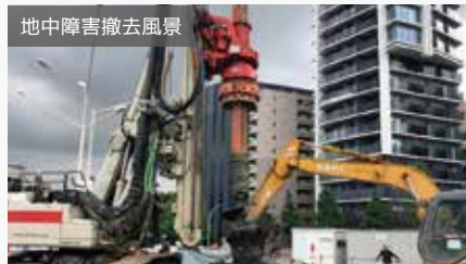
マルチドリル掘削機 (CH650) 運搬風景
