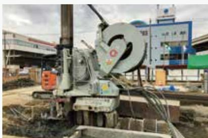
圧入装置にて無振動・無騒音でシートパイルを静荷重圧入および、引拔を行う工法です。ラジコン操作で自走しながら圧入・引拔ができ、水上工事や空頭制限のある現場などに対応ができます。併用工法としてウォータージェットも容易にセットできます。硬質地盤に対してもクラッシュパイラーでのシートパイル打設が可能です。
