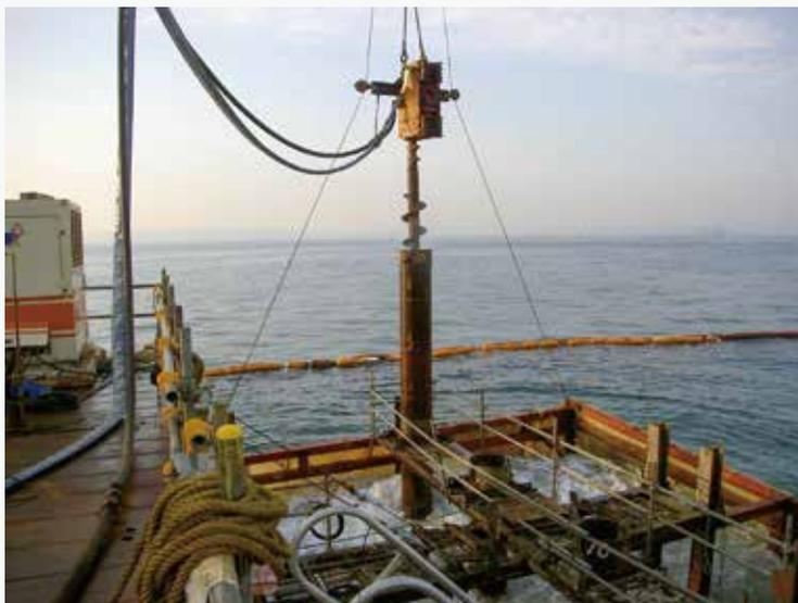
リングビット工法併用吊り下げ式工法を用いた海上施工の様子
