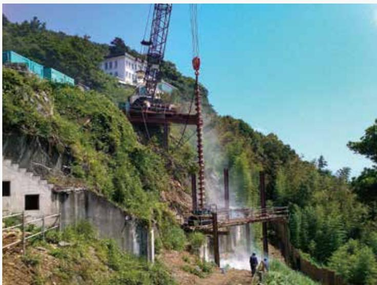
ロアードリル工法を用いた急傾斜地施工の様子
