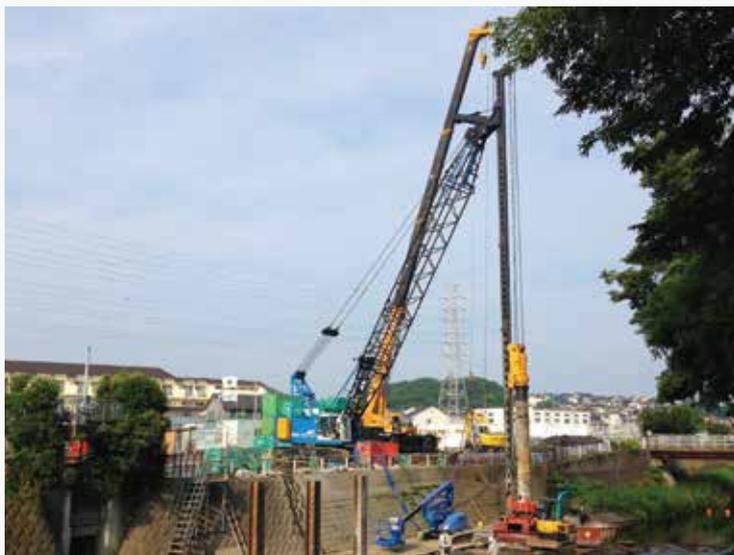
テレスコピックロックオーガを用いた地中障害撤去の様子
