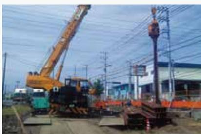
バイブロハンマ工法は H 形鋼やシートパイルに対し強制的に振動を伝達させ、先端・周囲の摩擦抵抗を一時的に低減させて打設、引拔を行う工法です。サイレントパイラー工法同様、ウォータージェットを併用することができ礫層、固結土などの硬質地盤への対応も可能です。
