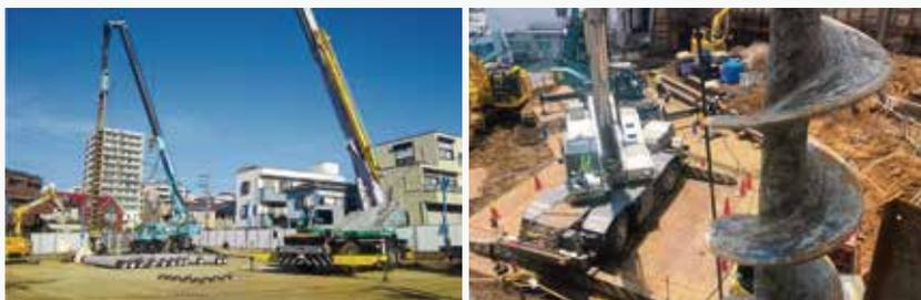
アボロンセメントミルク工法は、既製コンクリートパイプを用いたプレボーリング工法の一つです。本工法はスパイラルオーガと先端ビットにより掘削液を注入しながら地盤を掘削し、所定の深度まで達したら根固め液に切り替えて支持層の土砂の掘削、攪拌を行います。リーダを装着することで鉛直精度を保った施工が可能となっています。
