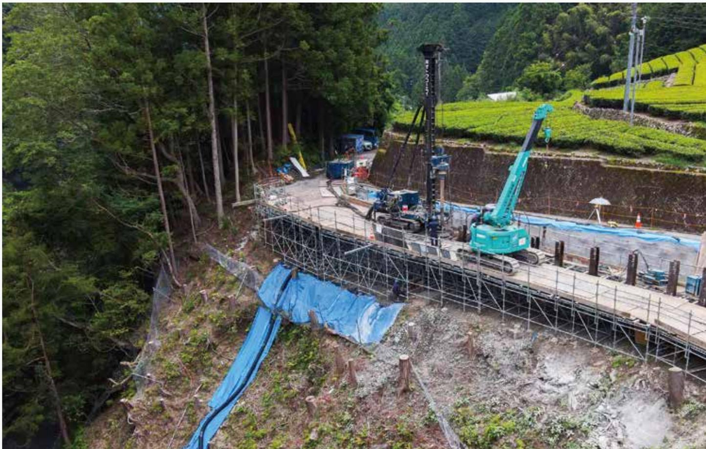
送電線基礎工事における一般重機の進入が困難な場所での搬入・施工を独自開発の機械を用いることによって実現。
