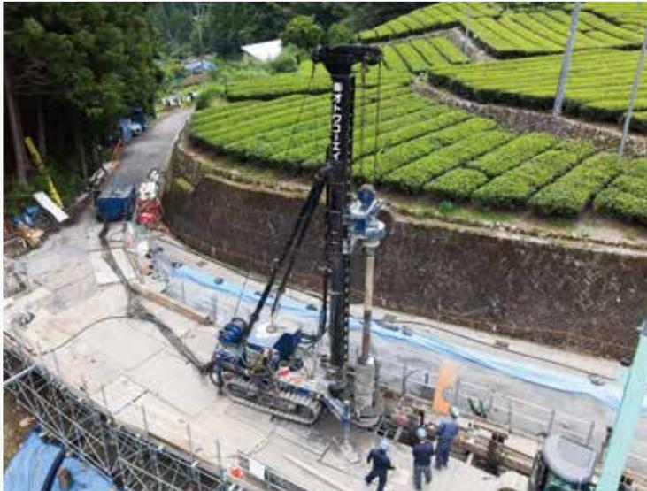
OTO® 掘削機を用いた抑止杭打設施工風景
