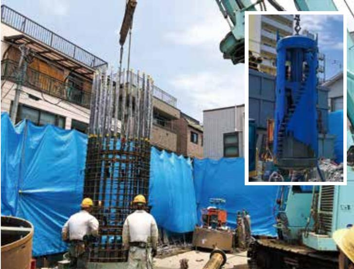
場所打ち杭施工の様子と掘削機 (右)
