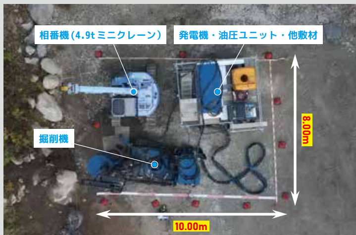
障害撤去工事時 資機材配置イメージ写真
