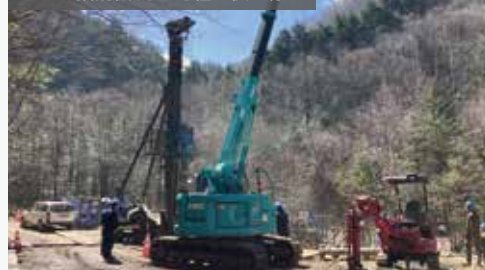
OTO® 掘削機 施工地組立後の様子
