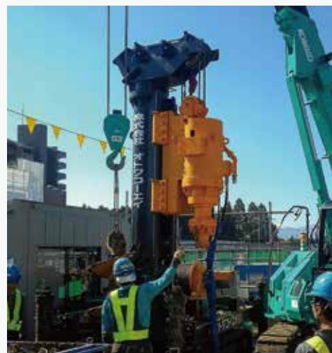
東京都町田市 (OTO® ドリル工法)
