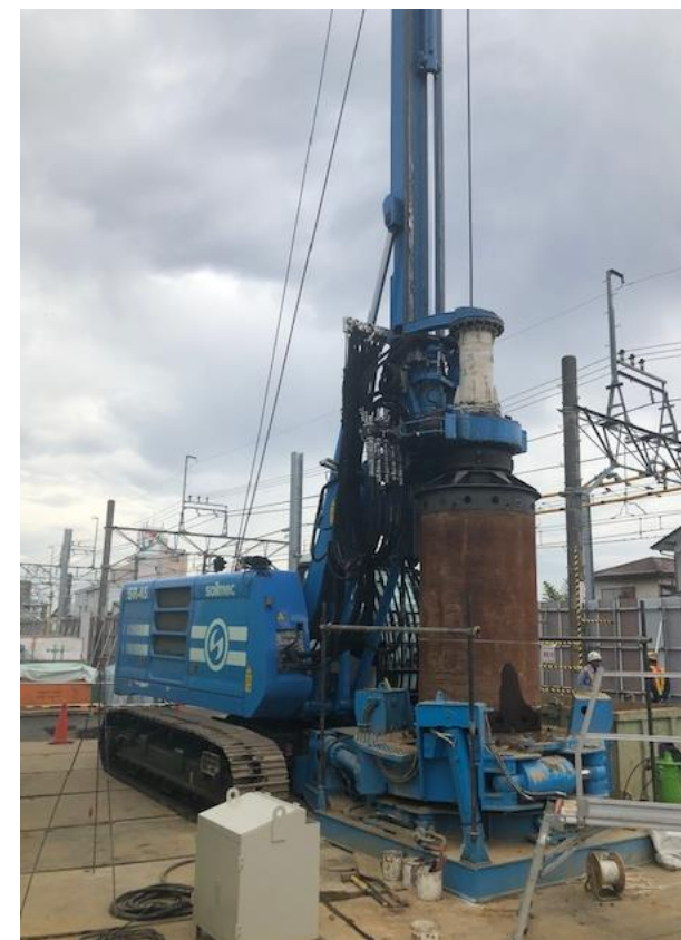
OT0ハイブリットドリル工法
