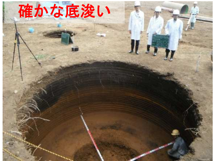
浅層掘削後の状況 φ5500
