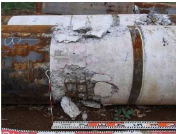
曲げ試験(試験後状況)
