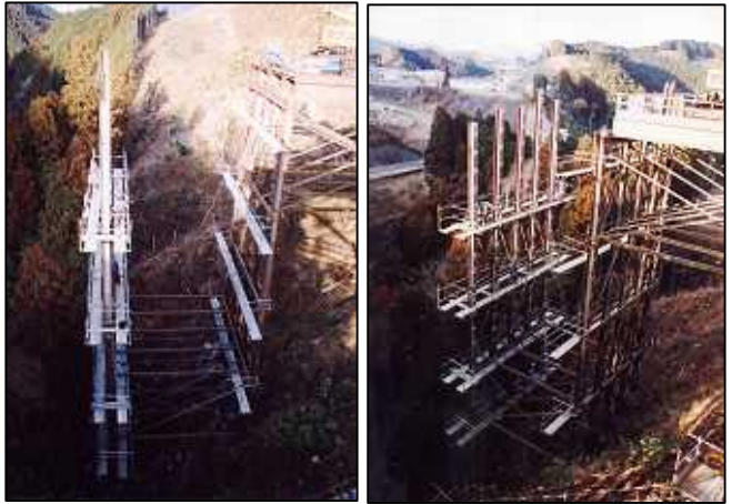
ブラケット足場組立状況
